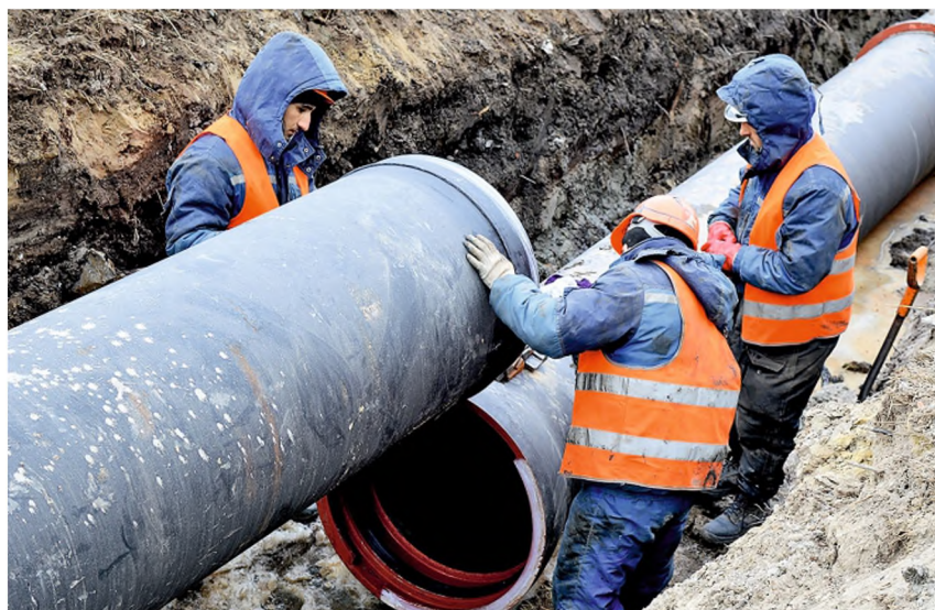
Монтаж трубопровода из ВЧШГ-трубы Ду1000 мм
