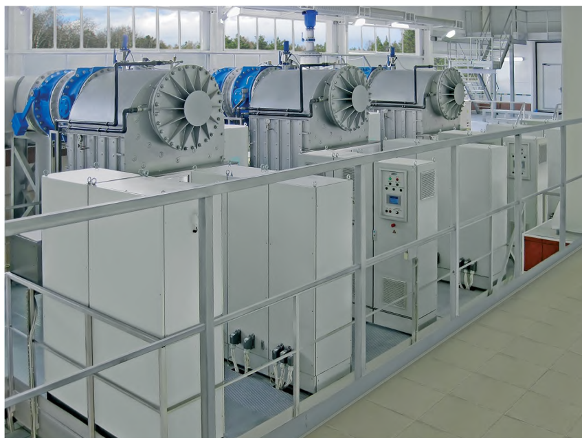
Рисунок 2. Установки УФ-обеззараживания на Слудинской ВС
