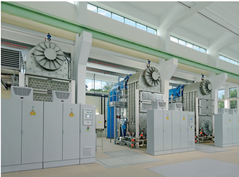
Рисунок 4. Установки УФ-обеззараживания на станции Кмедьер г.Будапешта
